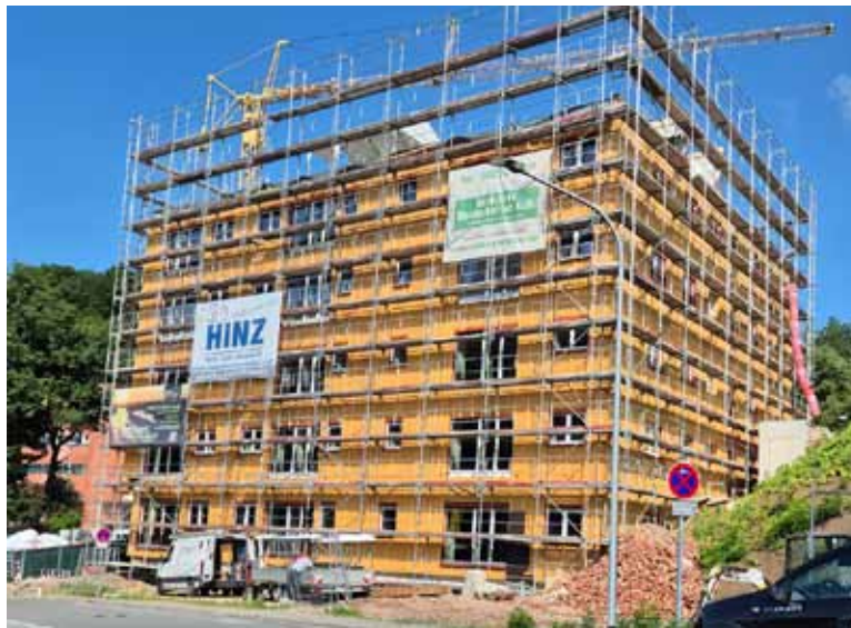
Das ehemalige Laborgebäude nimmt Gestalt an...
